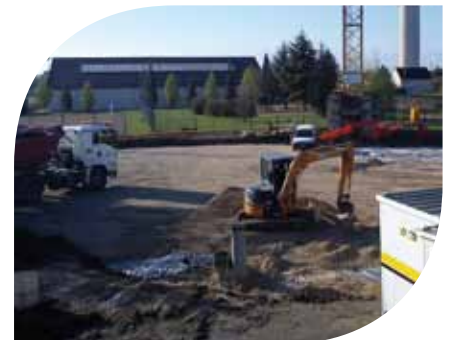
Terrassement du terrain - plateforme en construction
