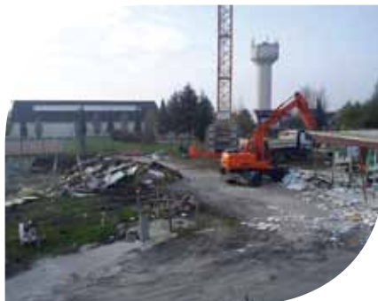
Démolition des anciens bâtiments et désamiantage du Point Accueil Jeunes
