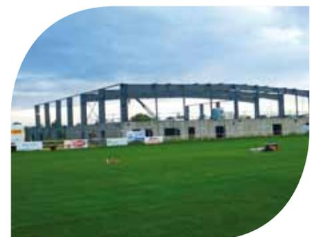
Pose de l'ossature métallique pour le soutien de la charpente
