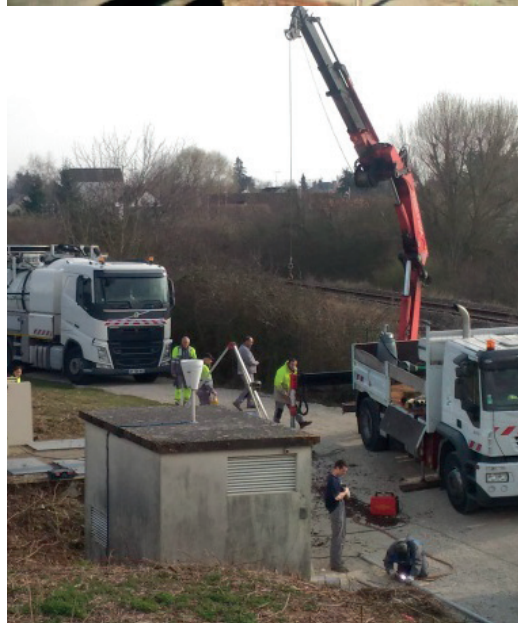
Remplacement des pompes sur le poste Eaux Usées et Eaux Pluviales de pôle 45 à Ormes
