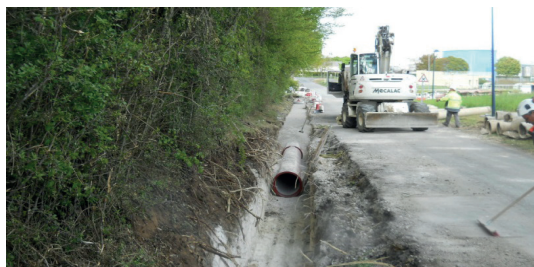
Semoy - rue de la Gourdonnerie : réhabilitation du réseau d'eaux pluviales par des travaux en tranchée ouverte
