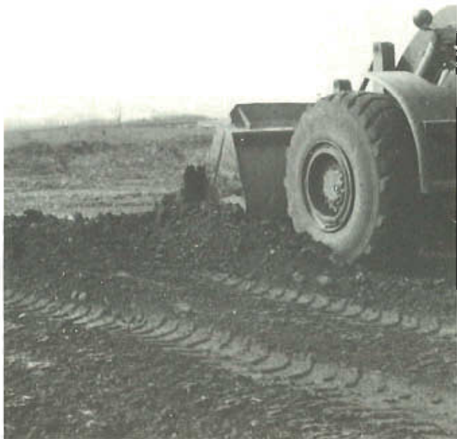
Deuxième passe pour le décapage de l'horizon inférieur
