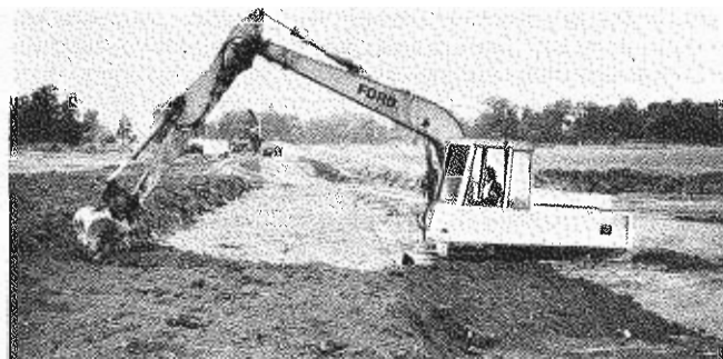
Régalage à la pelle hydraulique.
