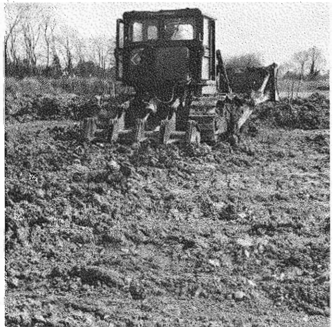
Passage du riper sur un soubassement constitué de remblai avant dépôt des terres de recouvrement
