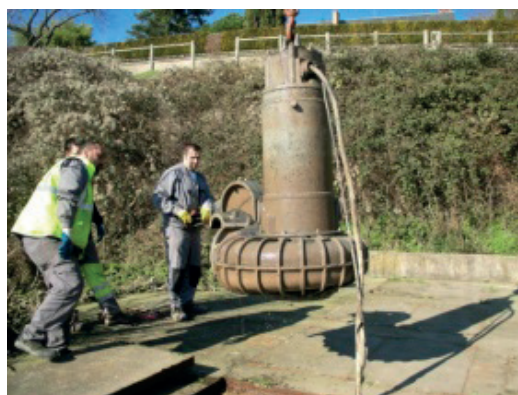
Changement d'une pompe de 55 kW - 436 l/s à la station Roche à Saint-Jean-de-la-Ruelle par le service assainissement
