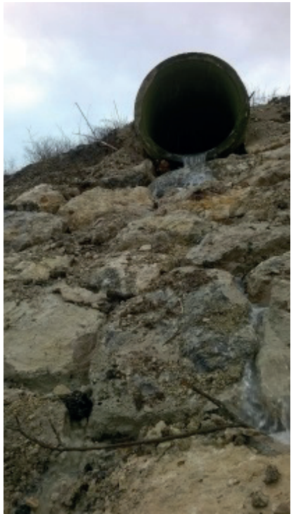
Enrochement arrivée Eaux Pluviales dans le bassin pole 45 à Ormes
