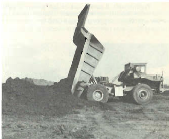
Chaque fois que ce sera possible on préconisera une formule de transfert du sol économisant le transport des terres par véhicules bennes. Ci-dessus un demper.
