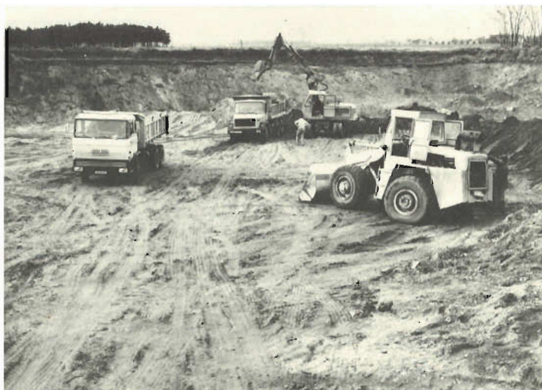
Nivellement du fond et régularisation des talus
