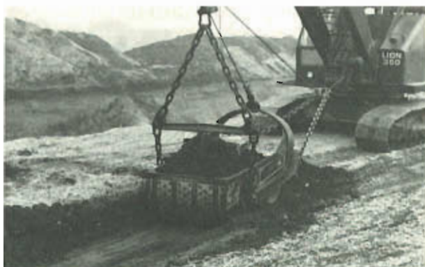
Décapage sélectif — horizon humifère — à l'aide du godet de la dragline
