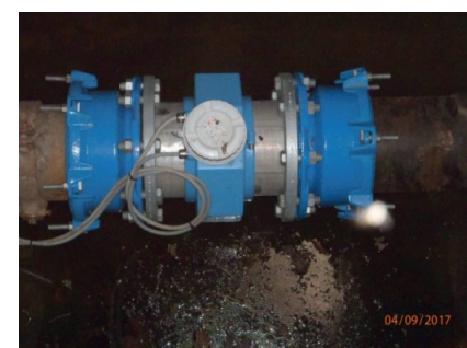
Débitmètre électromagnétique en sortie de la commune de Saint-Hilaire-Saint-Mesmin
